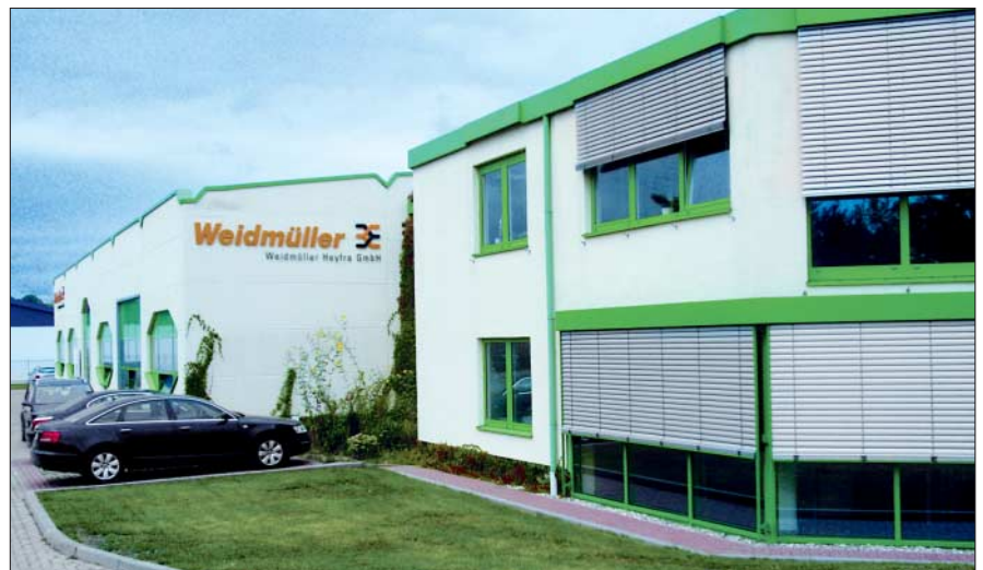
Bild 1: Das Hauptgebäude der Weidmüller Heyfra GmbH in Eisleben
