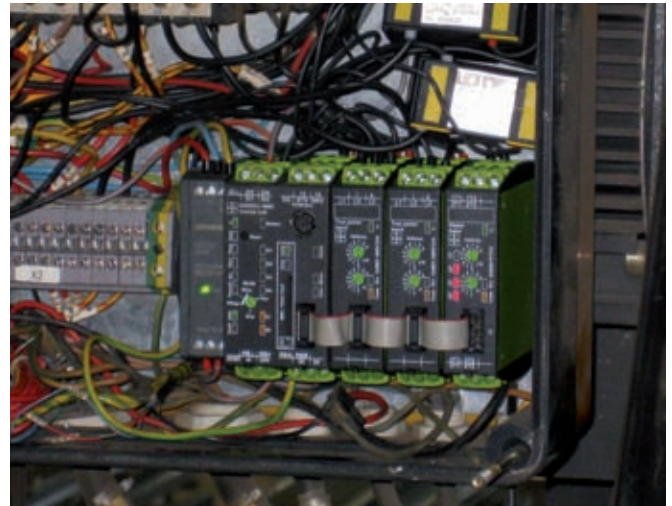
Kein Problem beim Einbau: Die kompakten WatchDog-pro-Module benötigen nur wenig Platz im Schaltkasten und bringen trotzdem umfangreiche Speichermöglichkeiten mit.
