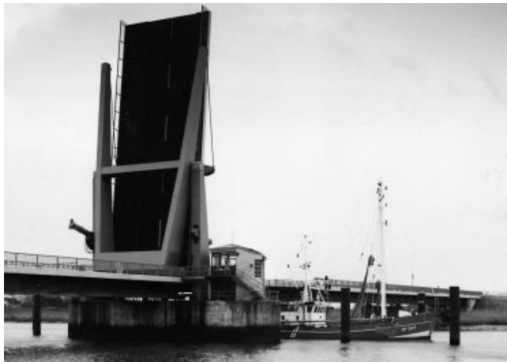
Beispiel auch für die neue Steuerung: Eine Procontic T200-S steuert den Mechanismus einer Klappbrücke über die Oste und ist für die Signalanlagen verantwortlich, die Schiff- und Straßenverkehr regeln
