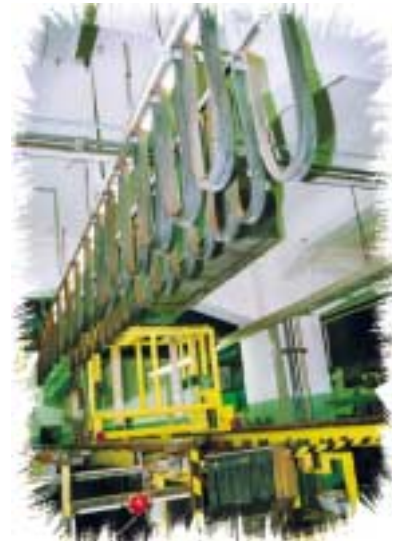
Die bruchgefährdeten alten Schleppleitungen in der Galvanik...
