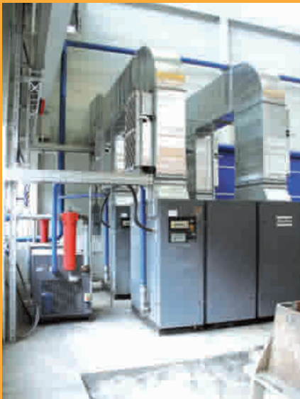
Kompressorstation mit zwei öleingespritzten Verdichtern in der gerade eröffneten Halle.
