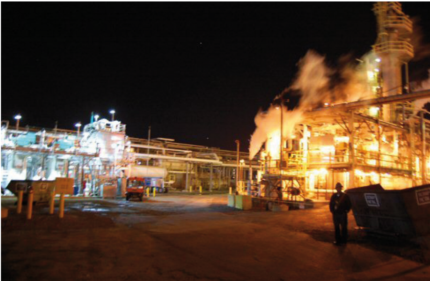
Bild 4: Raffinerie beleuchtet mit weißen LEDs (links) und HPS-Lampen (rechts).
