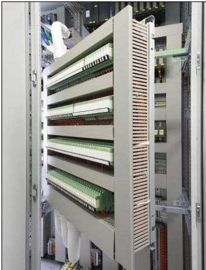
Bild 2: PLC-Relais passen die Spannungspegel der Feldsignale an die der Steuerung an.
